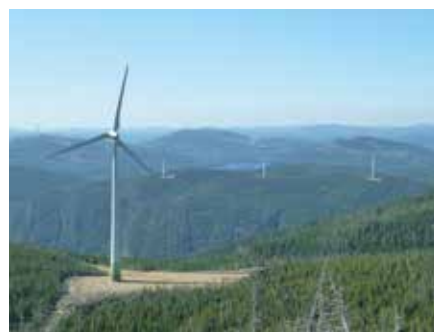
Parc éolien de la Seigneurie de Beauré, 2015.
