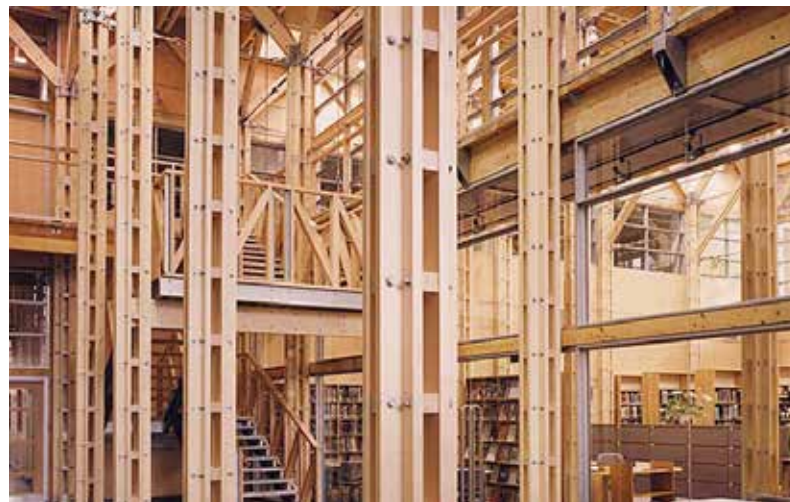
Intérieur du bâtiment qui abritait FPInnovations jusqu'en 2017. Parc Technologique du Québec Métropolitain.
