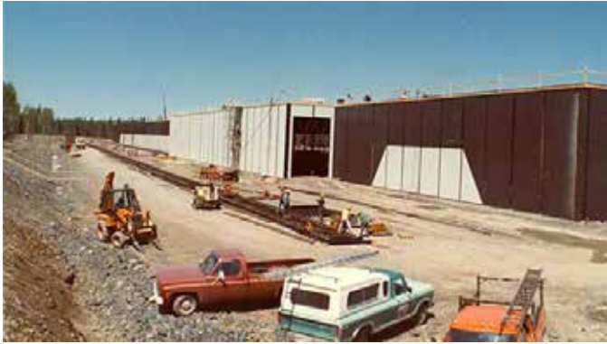
Construction de l'usine PANVAL à Sayabec en 1982. Source : https://www.uniboard.com/fr/qui-nous-sommes .
