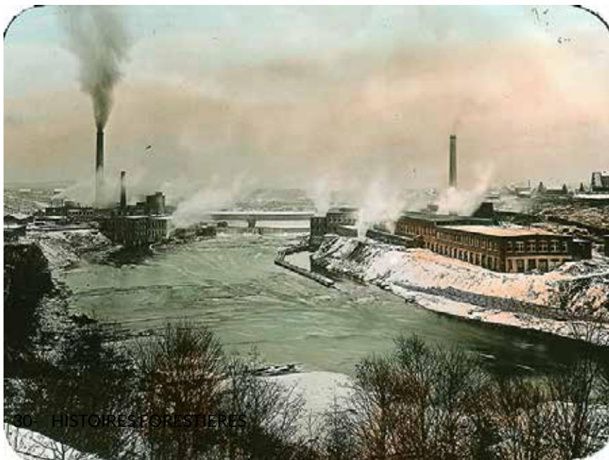
Usine de la Brompton Pulp & Paper Company, QC, vers 1930.
