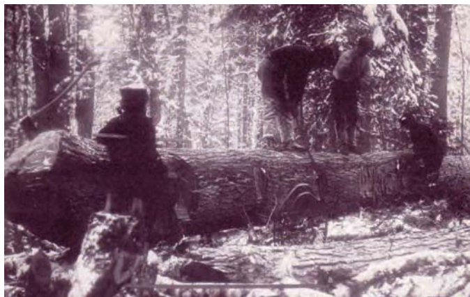
Équarrissage d'une pièce de bois dans la région de l'Outaouais en 1873. Remarquez le caractère exceptionnel de cet arbre en comparaison avec les autres spécimens dans le paysage forestier.
