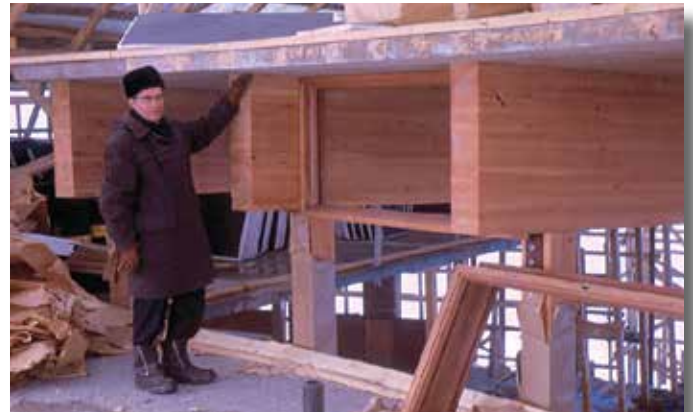
M. Edgar Porter, ancien doyen de la Faculté de foresterie, de géographie et de géomatique (1963-1971), pendant la construction du pavillon.
